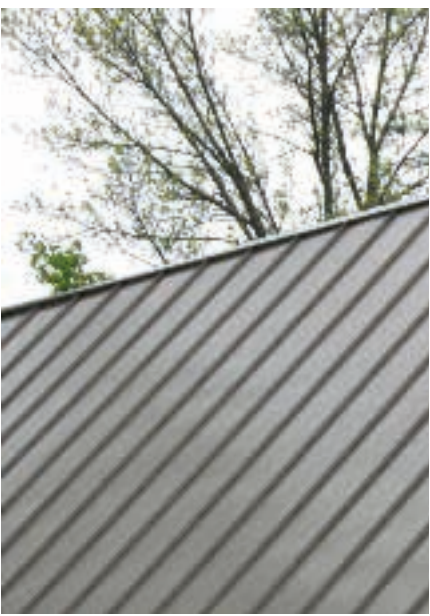
De eksisterende tage renoveres og beklædes med en mørk højfalset eller trapezstålplade
