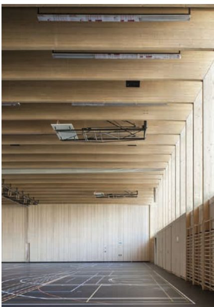
Rammer og gitterværk udføres i limtræ
