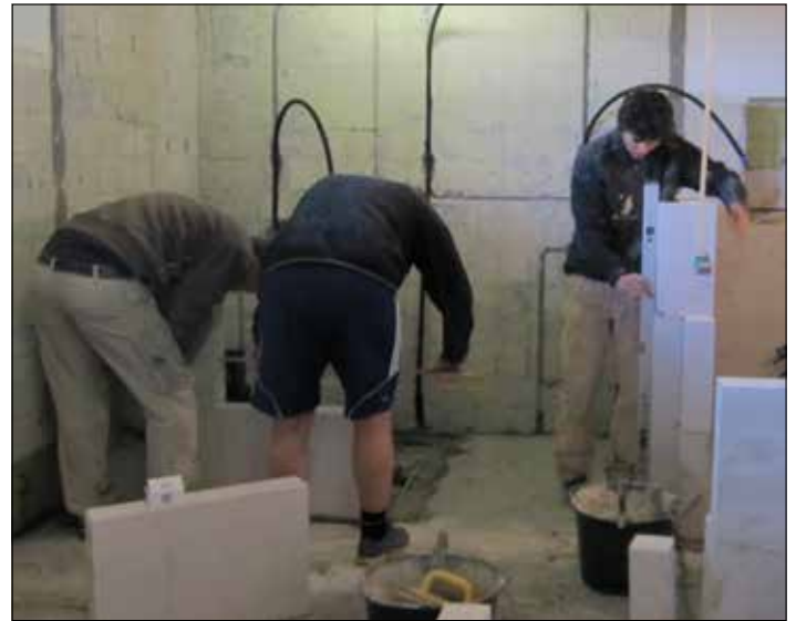
Renovering af omklædningsrummene
